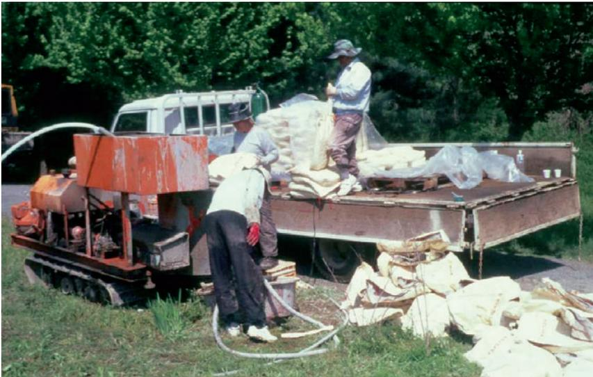
Abb. 5 Verpressung mit aus Deutschland geliefertem Verpressmaterial für die Erdwärmesonden-Versuchsanlage in Daejon, Südkorea
