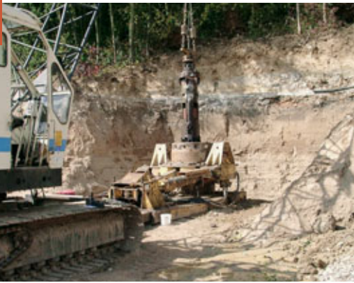
△ Abb. 8 Bohrarbeiten am Brunnen 1, September 2008
