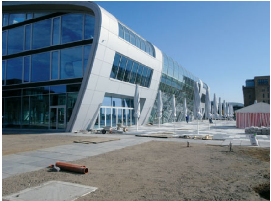
▷ Abb. 9 Brunnen 8 (Deckel vorne links) mit dem fast fertiggestellten 5-Sterne-Hotel Kameha Grand im Hintergrund; Zustand Oktober 2009.
