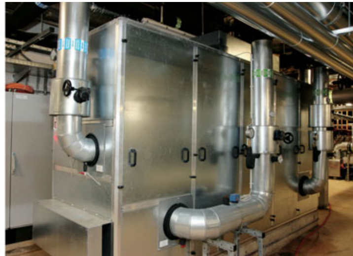
△ Abb. 3 Grundwasser-Wärmetauscher (links) und Wärmepumpe (rechts) in der Technikzentrale im Untergeschoss BT D
