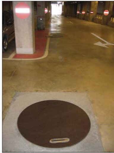
Abb. 3: Vorgefertigter Unterverteiler beim Einbau (links, 2007, Photo Form Group) und der heutige Zustand mit den Deckeln der Unterverteiler in einer Reihe im Boden der Tiefgarage (rechts)
