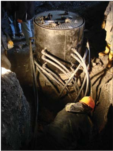
Abb. 3: Vorgefertigter Unterverteiler beim Einbau (links, 2007, Photo Form Group) und der heutige Zustand mit den Deckeln der Unterverteiler in einer Reihe im Boden der Tiefgarage (rechts)
