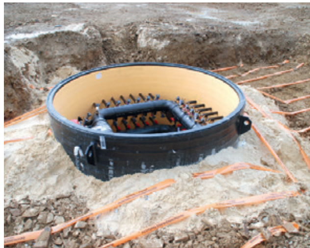
Abb. 5 – Verteiler für das Feld mit 50 Erdwärmesonden beim Einbau (Juni 2012)
