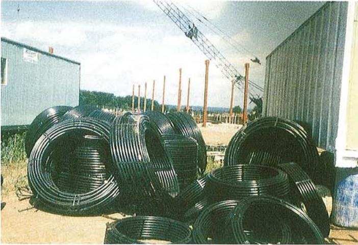
Abb. 7: Weitere zum Einbau vorbereitete Einfach-U-Rohr-Erdwärmesonden von 300 bzw. 500 Fuß (91,4 bzw. 152,4 m) Länge für die Copper Hill School.
