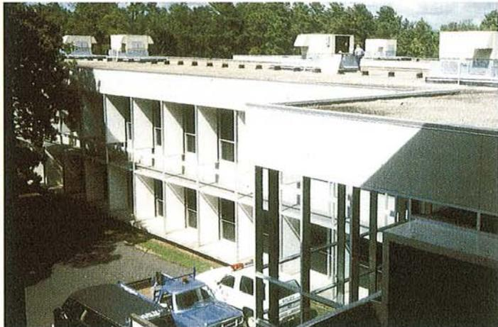
Abb. 5: Richard Stockton College, C-Flügel (Naturwissenschaften); es sind sechs der insgesamt 66 auf dem Dach montierten Wärmepumpen zu sehen, die an ein zentrales Erdwärmesondenfeld angeschlossen sind. Deutlich ist auch zu erkennen, daß die Wärmepumpen nur etwa die Hälfte der ursprünglich für Airc conditioner genutzten Montagerahmen benötigen.
