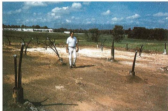
Abb. 6: Erdwärmesondenfeld der Copper Hill School im Bau; als Maßstab dient der Anlagenplaner, Howard Alderson.
