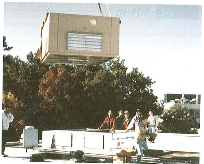
Abb. 15: Austausch der Rooftop-Airconditioner gegen Wärmepumpen
