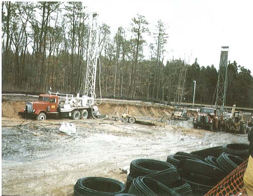
Abb. 17: Bohrarbeiten für die Erdwärmesonden
