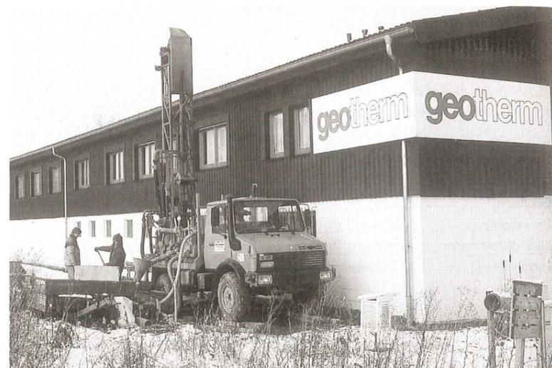
Bild 6: Winterliche Bohrarbeiten für Erdwärmesonden
