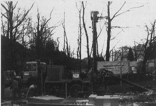
Abb. 3: Probebohrung zur Erdsondenanlage Kochel am 12.1.1993 an der südlichen Grundstücksgrenze
