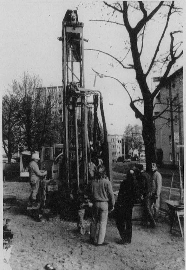
Abb. 14: Bohrarbeiten im November 1993, Frankfurt-Höchst
